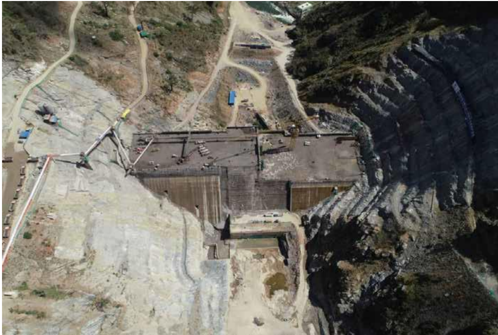
Kafue Gorge Lower under construction
